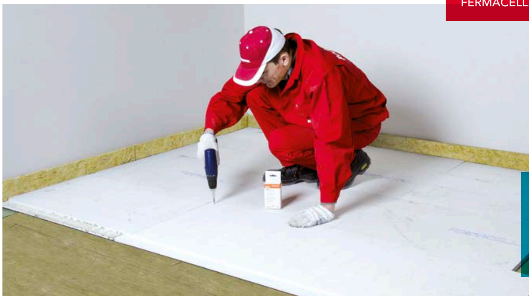
Przykładowe rozmieszczenie łączników dla płyt FERMACELL 2E22
