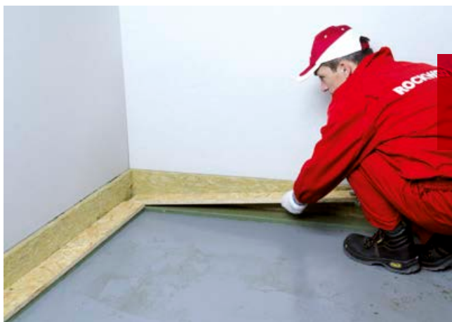
Wykonanie drugiej warstwy brzegowego pasa usztywniającego z płyt OSB-3.
