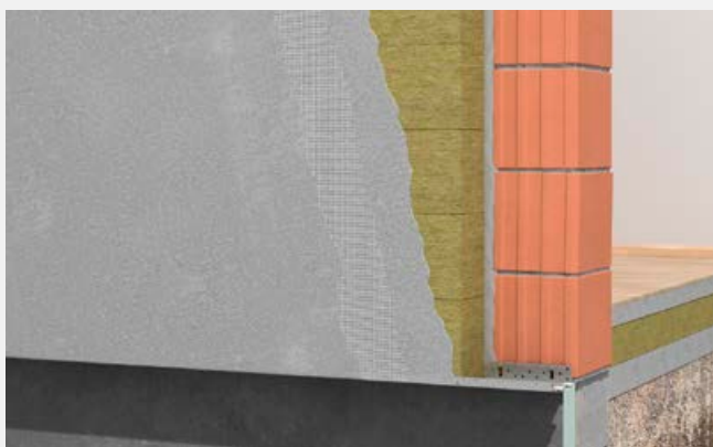
Nałożenie zaprawy zbrojącej i wtopienie siatki zbrojącej z włókna szklanego.
