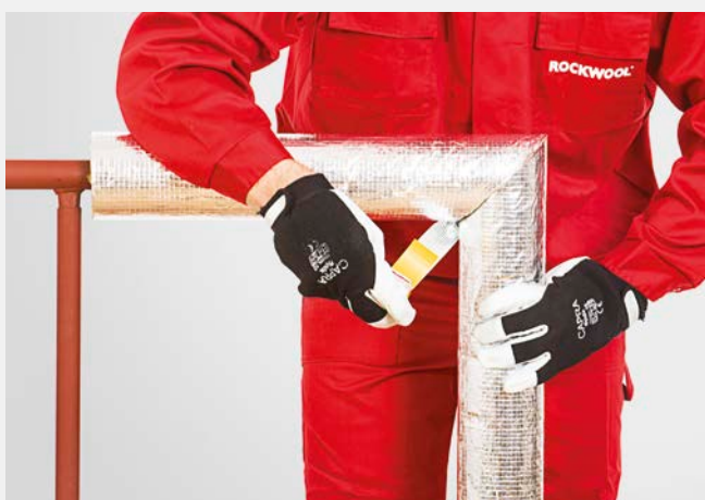
Zabezpieczenie połączenia poprzecznego otulin samoprzylepną taśmą aluminiową.
