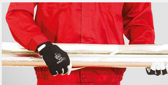
Ściągnięcie taśmy PE z zakładki samoprzylepnej.
