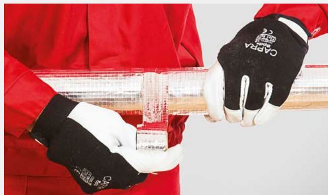
Zabezpieczenie połączenia poprzecznego otulin samoprzylepną taśmą aluminiową.
