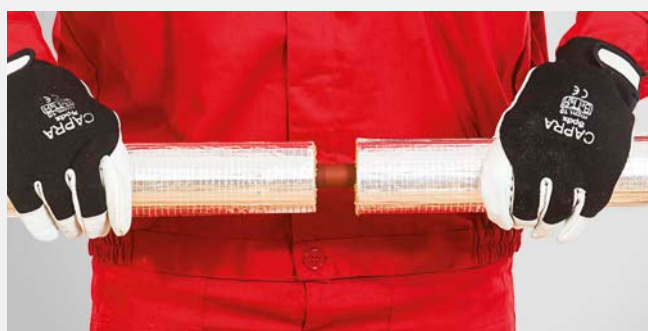
Połączenie poprzeczne dwóch odcinków otulin.
