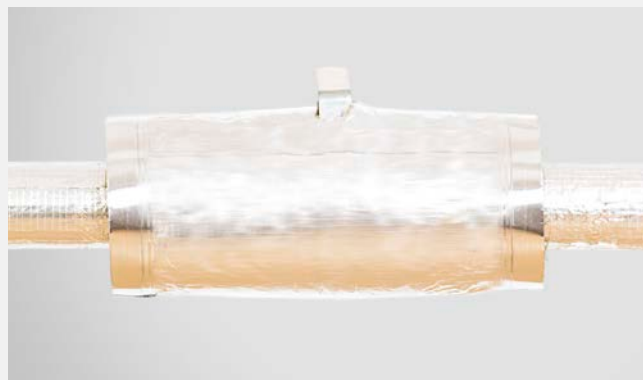
Gotowa izolacja zaworu przy użyciu ALU LAMELLA MAT.
