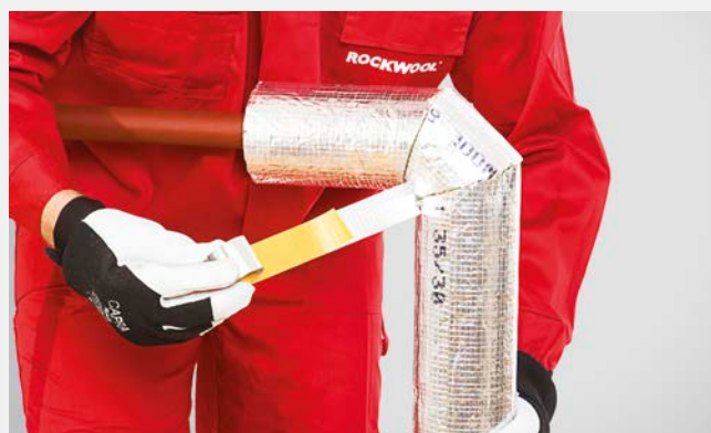
Sklejenie połączeń poprzecznych taśmą aluminiową.
