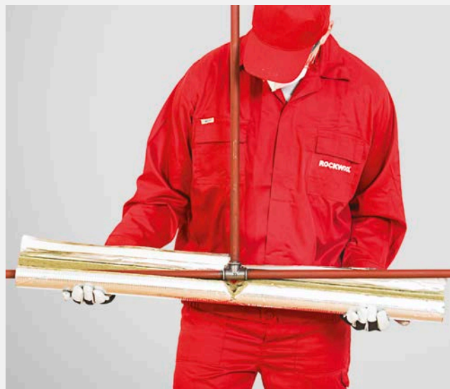
Nażłowanie dociętych elementów na odcinek poziomy i pionowy rury.
