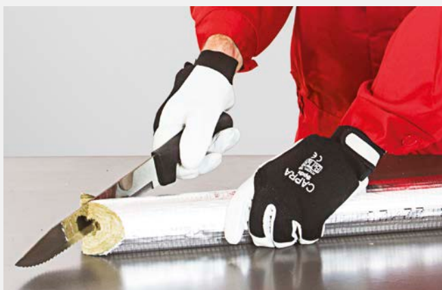
Wycięcie klina 2 \times 45^\circ w odcinku izolującym odgałęzienie rurociągu.
