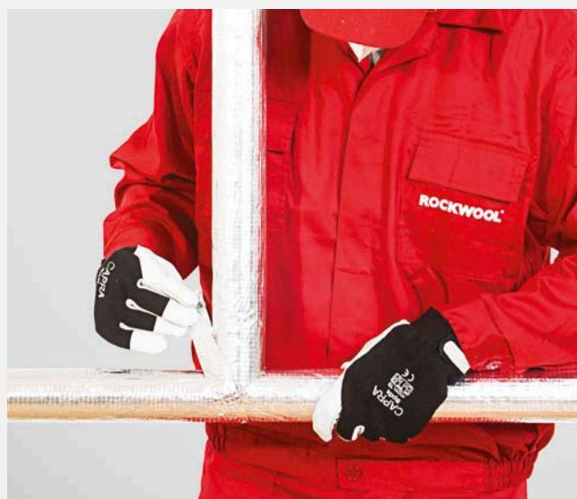
Sklejenie styków izolacji taśmą aluminiową.
