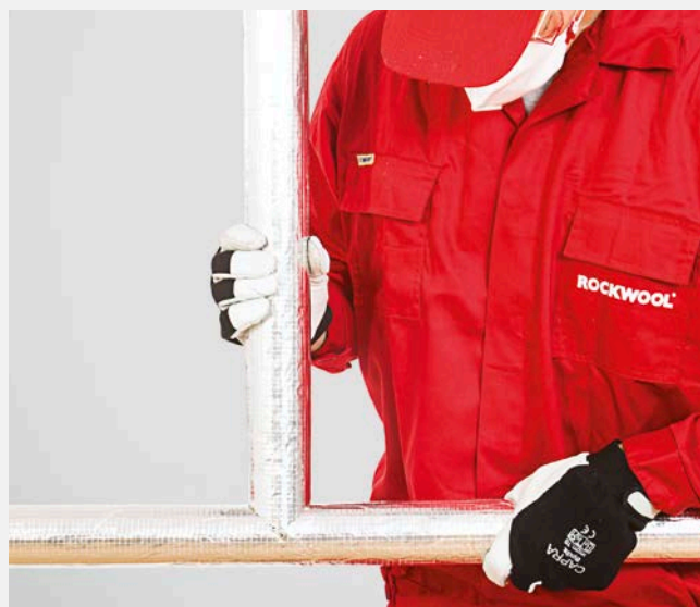
Dopasowanie łączonych odcinków.
