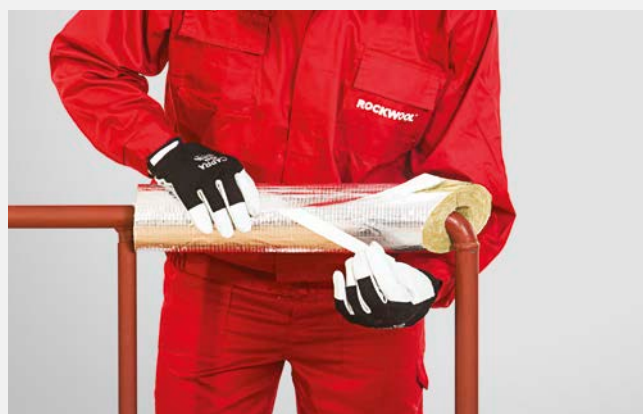
Sklejenie połączenia wzdłużnego zakładką samoprzylepną.
