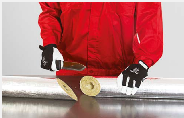
Rozcięcie otuliny pod kątem 45° na dwa elementy.
