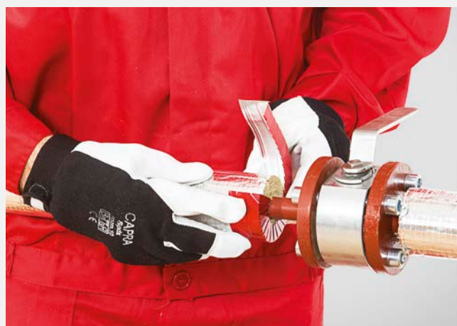
Zabezpieczenie zakończenia odcinka prostego izolacji przy zaworze mankietem aluminiowym.
