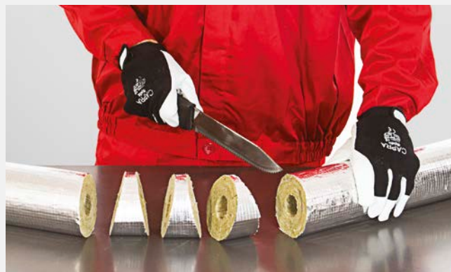
Wycinanie segmentów kolanowych.
