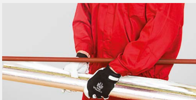
Nałożenie otuliny na odcinek prosty rurociągu.
