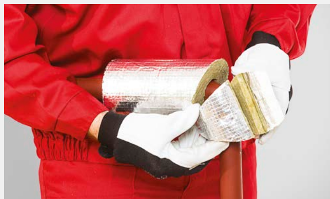
Montaż jednego segmentu kolanowego.
