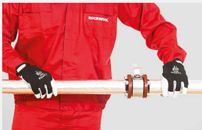
Wstępne zaizolowanie odcinków prostych instalacji do zaworu odcinającego.
