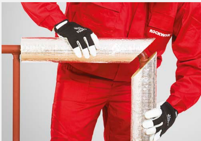
Dopasowanie obu elementów izolacji kolana.
