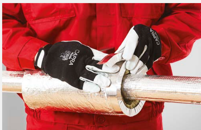
Zabezpieczenie zakończenia izolacji mankietem aluminiowym.
