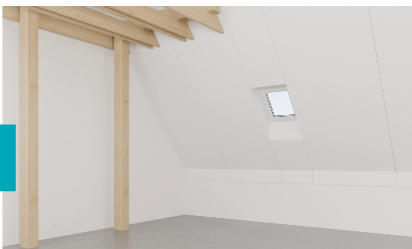
Montarea panourilor de gips-carton
