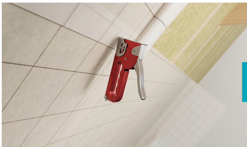
Instalarea barierei de vapori pe structura de lemn folosind clipsuri
